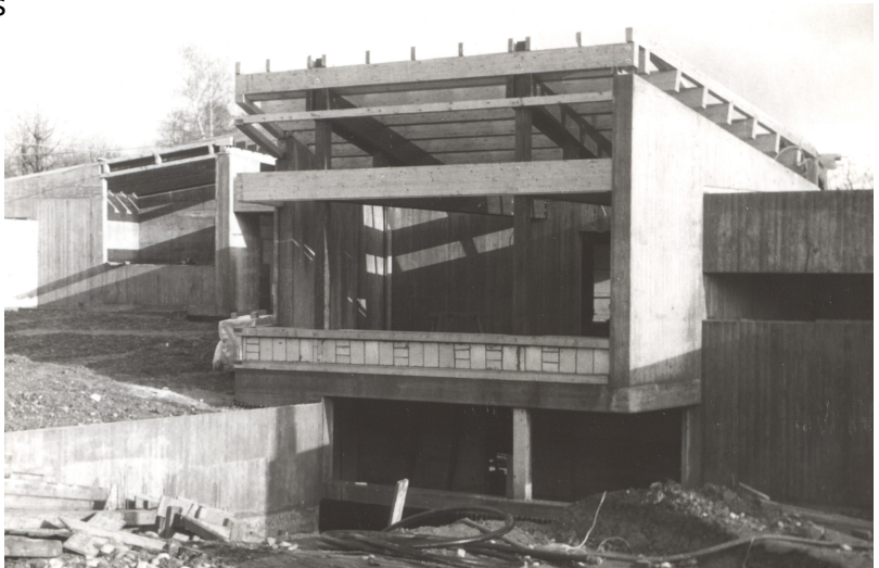
Rohbau Nov. 1972 Kleiner Saal
