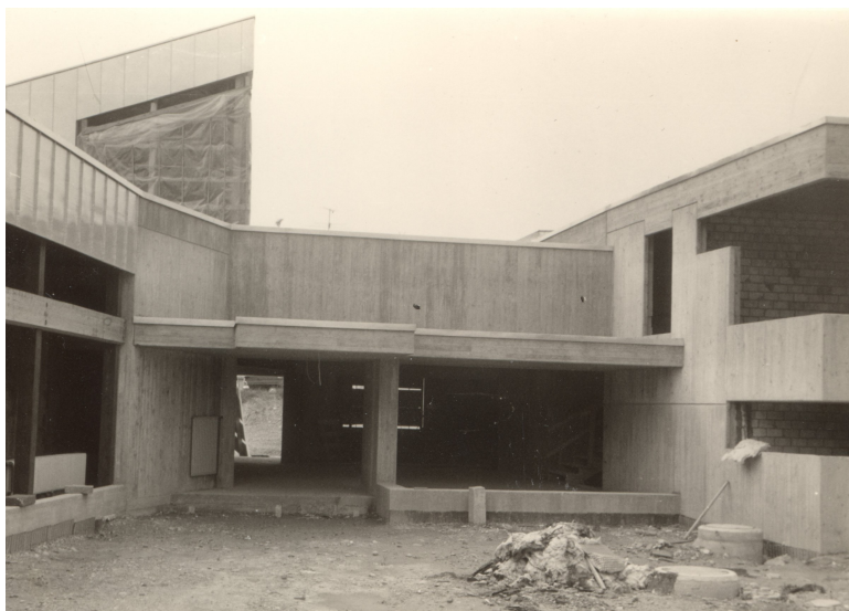
Rohbau Juli 1973 Haupteingang
